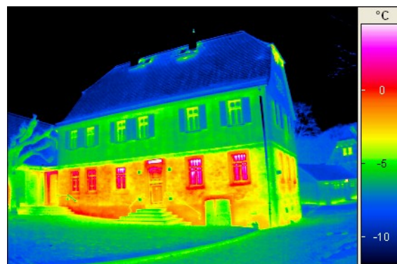
Thermogramm des Herrenhauses zeigt Bereiche mit höherem Wärmeverlust
